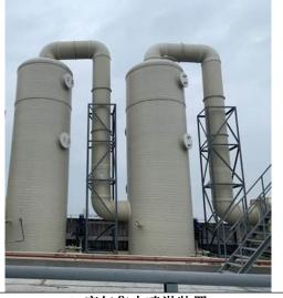
3#废气集中喷淋装置
