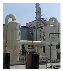
污水处理站废气处理装置
