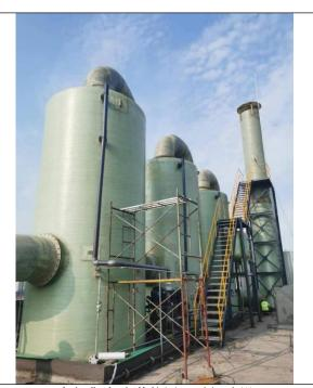
2#废气集中喷淋装置(重新建设)
