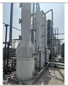
106 车间预处理装置 (两级水喷淋+一级碱喷淋)
